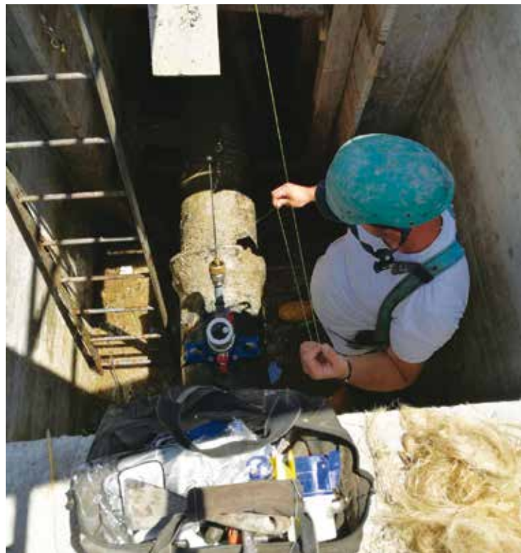
ACILIA - installazione della fibra in campo
